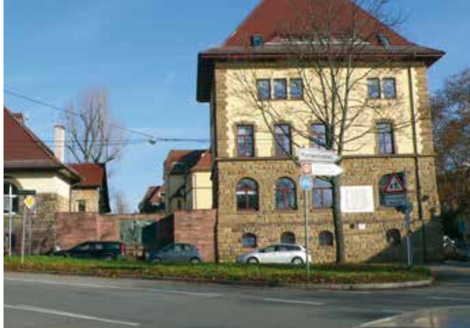
Hier soll der neue Platz entstehen
