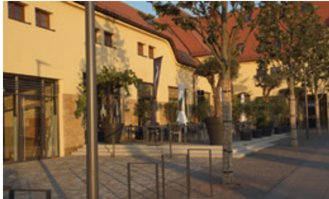
Neue Fassaden- und Bodengestaltung mit Bepflanzung im nord-westlichen Teil beim Ristorante Rusticone mit mediterraner Terrasse
