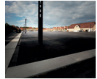
Blick über den ehemaligen Exerzierplatz dessen Charakter hinsichtlich des Denkmalschutzes erhalten wurde
