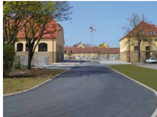
Bereits fertiggestellt: Die Zufahrt in das zukünftige Stadtteilzentrum von der Rommelstraße
