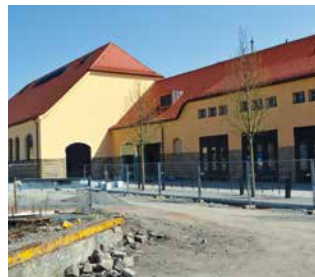
Am Haupteingang wird derzeit noch gearbeitet
