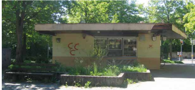
Ehemaliger Kiosk auf dem Nasplatz
