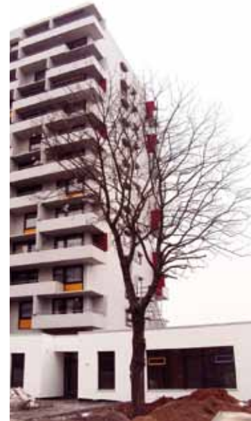
Der Neubau ist fertiggestellt, die Grünanlage wird angelegt
